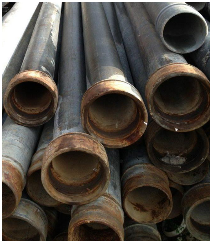
Рисунок 1.2 – Труби з пошкодженими манжетами та розтрубами
