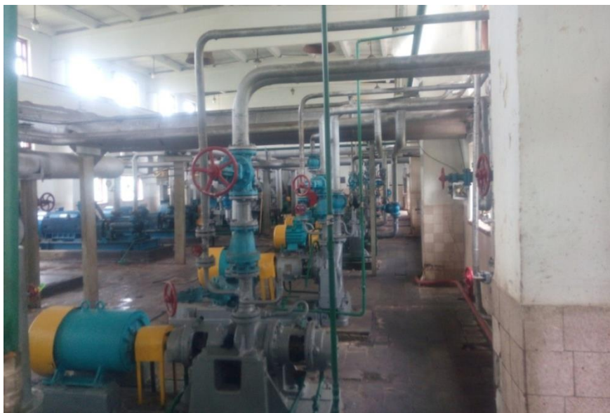
Рисунок 5.12 – Загальний вигляд розташування відцентрових насосів на Долинському ГПЗ
