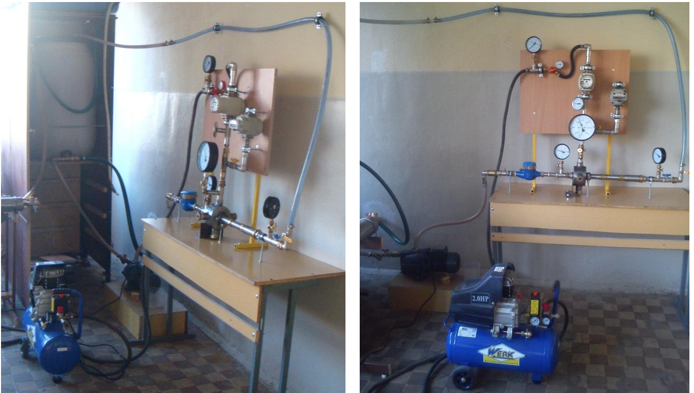
Рисунок 7 – Лабораторна ежекторна водоповітряна установка
