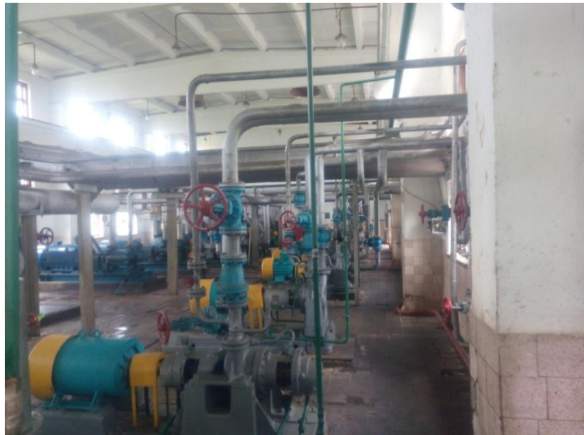
Рисунок 14 – Загальний вигляд розташування відцентрових насосів на Долинському ГПЗ
