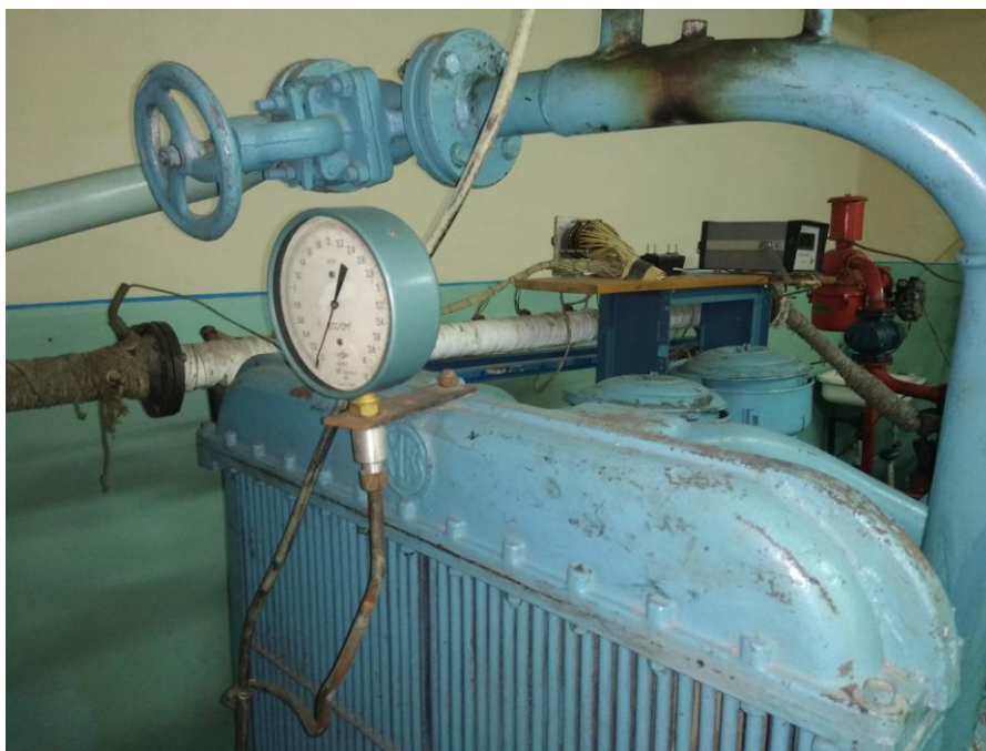
Рисунок 4.9 – Манометр для вимірювання тиску стисненого компресором газу
